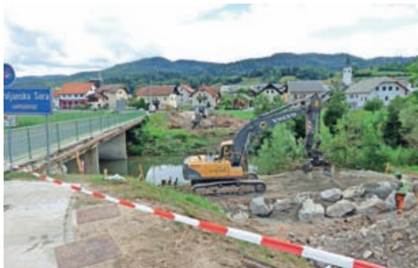
V preteklih dneh so začeli pripravljala dela za gradnjo novega mostu čez Poljansko Soro v Gorenji vasi. FOTO: JURE FERLAN
